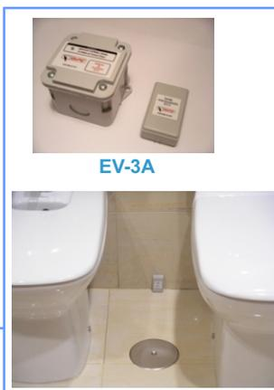
**EJEMPLO DE INSTALACIÓN del detector EV-3A.**
